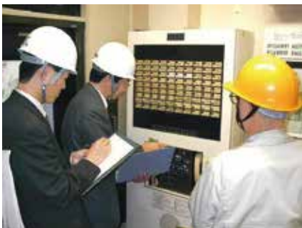
現地調査の様子
